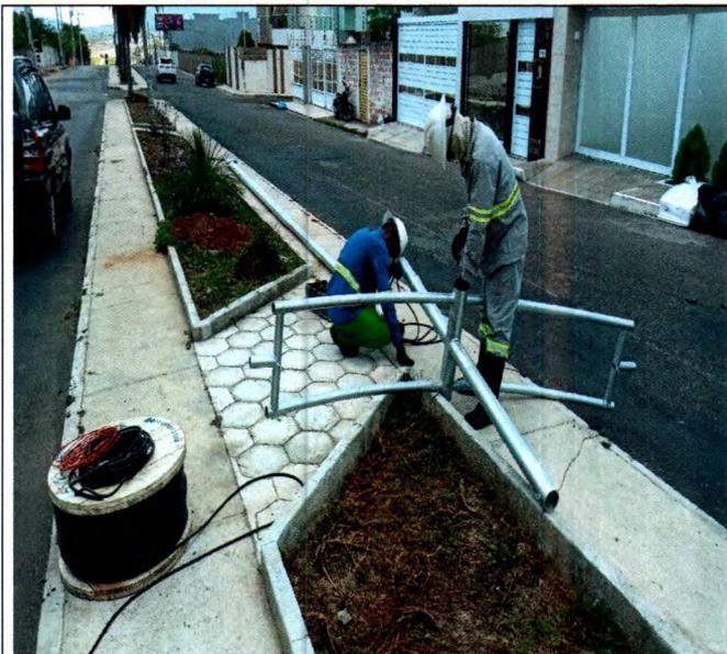
Foto 05: Passagem de cabos para conexão dos circuitos existentes.
