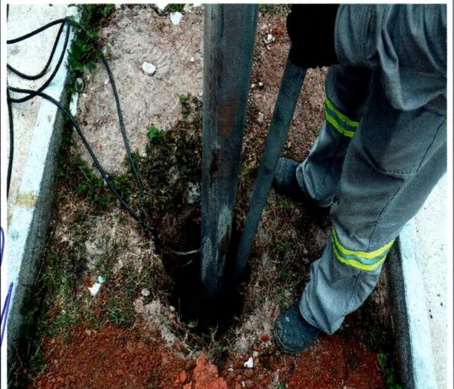
Foto 04: Escavação manual, concretagem e assentamento de postes.
