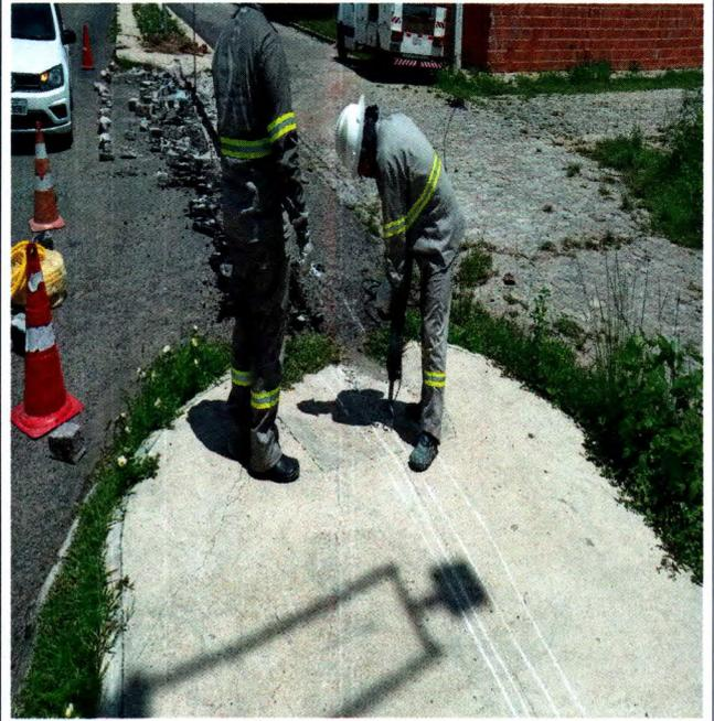
Foto 02: Escavação de vala, instalação de eletroduto e caixa de derivação.
