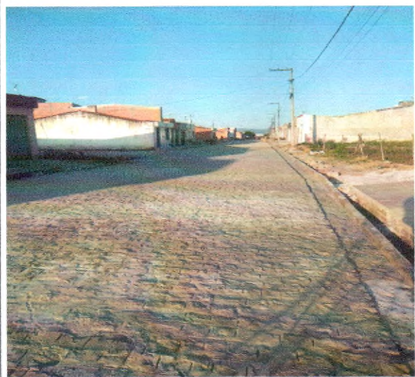
Foto 16: RUA JOSIVAL DOS SANTOS
