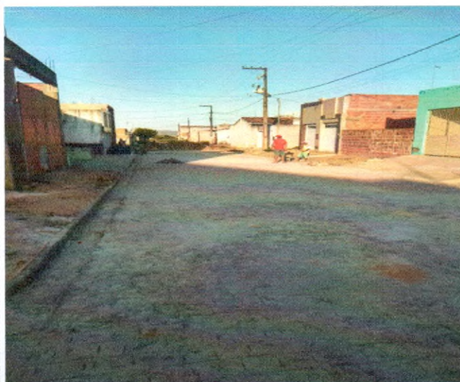
Foto 15: RUA JOSIVAL DOS SANTOS
