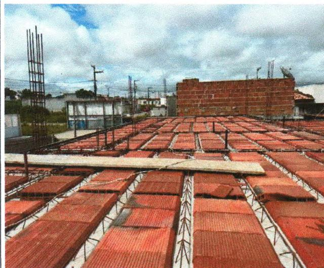
Foto 15: MONTAGEM DA LAJE PRE-FABRICADA
