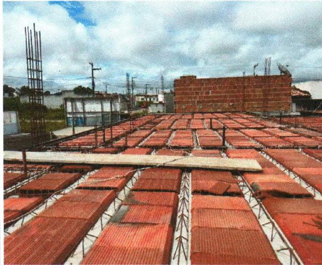
Foto 13: MONTAGEM DA LAJE PRE-FABRICADA
