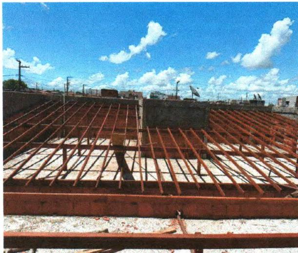
Foto 19: MADEIRAMENTO DO TELHADO
