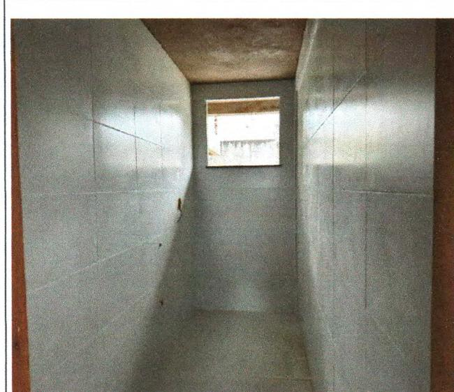
Foto 21: REVESTIMENTO E PISO CERÂMICO
