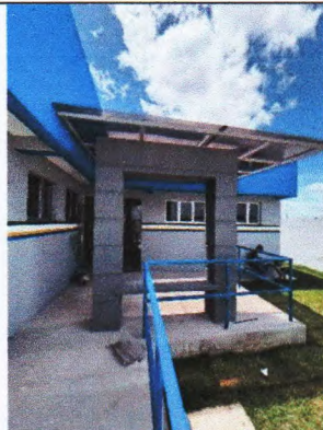
Foto 8: Fachada dos fundos
