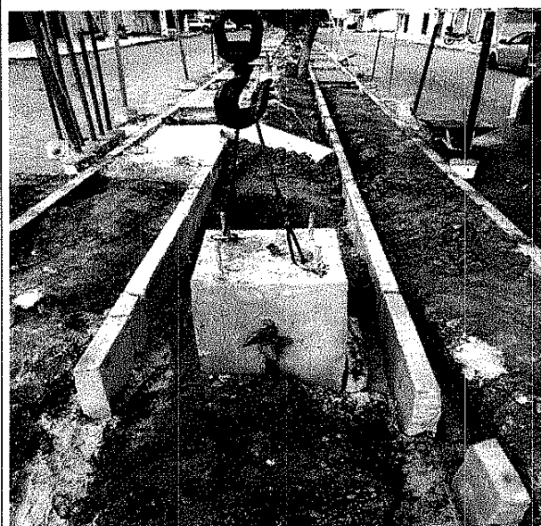
Foto 04: Sapata para sustentação de poste.
