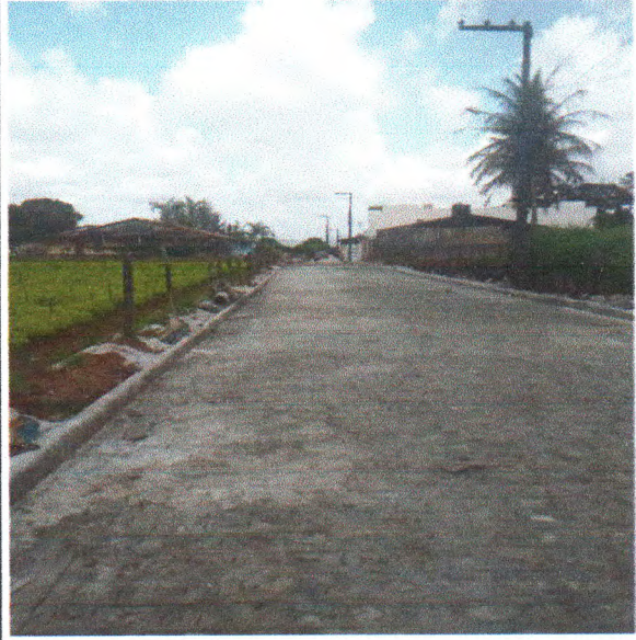
Foto 10: PAVIMENTAÇÃO DO TRECHO 01
