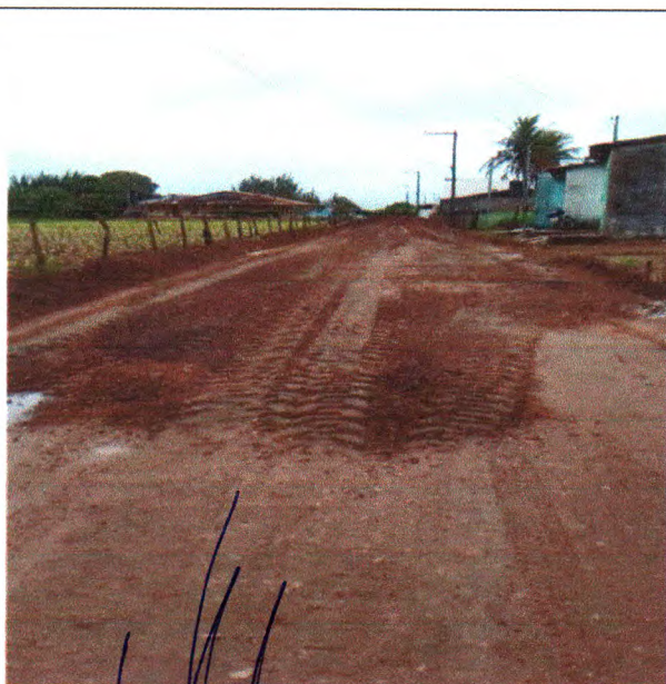
Foto 07: PAVIMENTAÇÃO DO TRECHO 01
