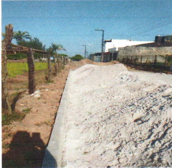
Foto 09: PAVIMENTAÇÃO DO TRECHO 01
