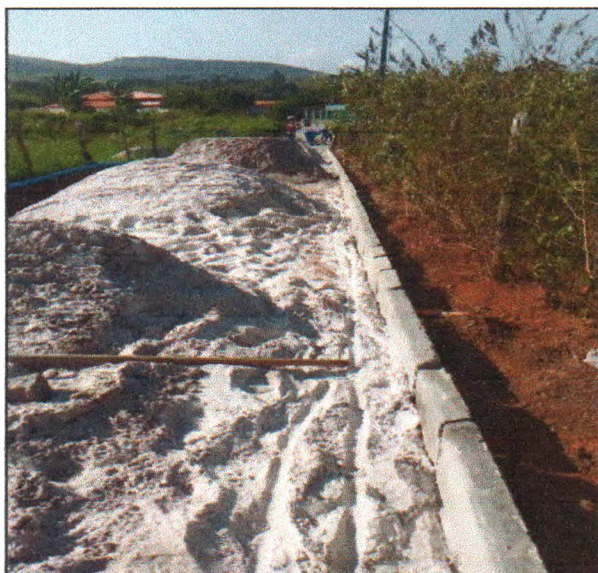
Foto 05: PAVIMENTAÇÃO DO TRECHO 03
