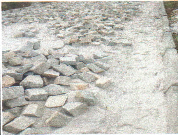
Foto 13: PAVIMENTAÇÃO DO TRECHO 02
