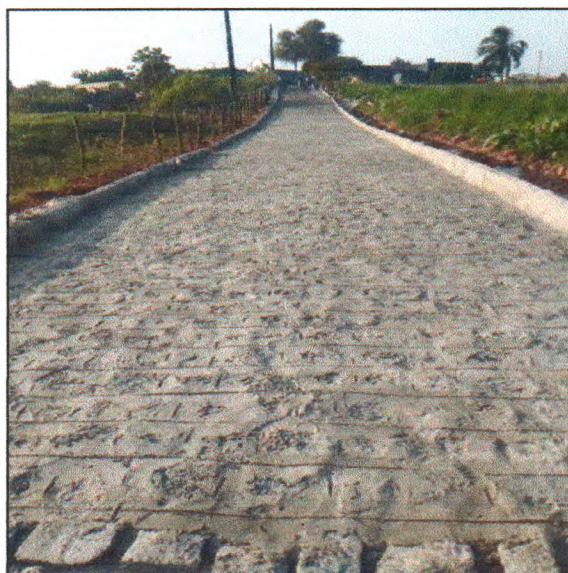
Foto 06: PAVIMENTAÇÃO DO TRECHO 03
