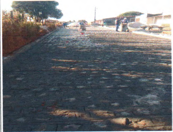
Foto 14: PAVIMENTAÇÃO DO TRECHO 02
