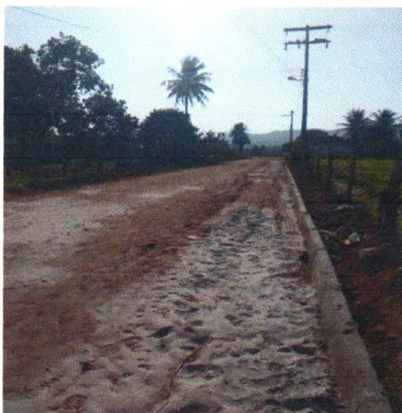
Foto 08: PAVIMENTAÇÃO DO TRECHO 01
