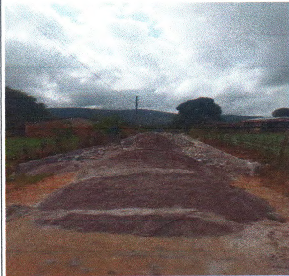
Foto 12: PAVIMENTAÇÃO DO TRECHO 02
