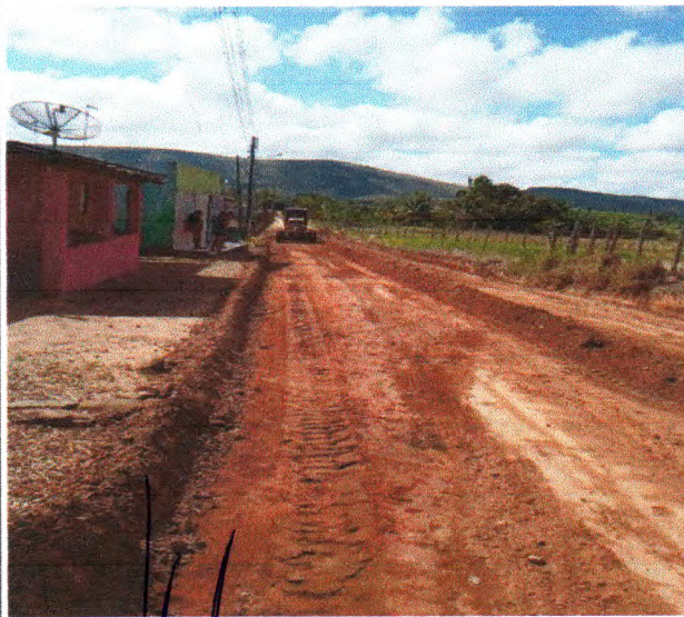
Foto 11: PAVIMENTAÇÃO DO TRECHO 02
