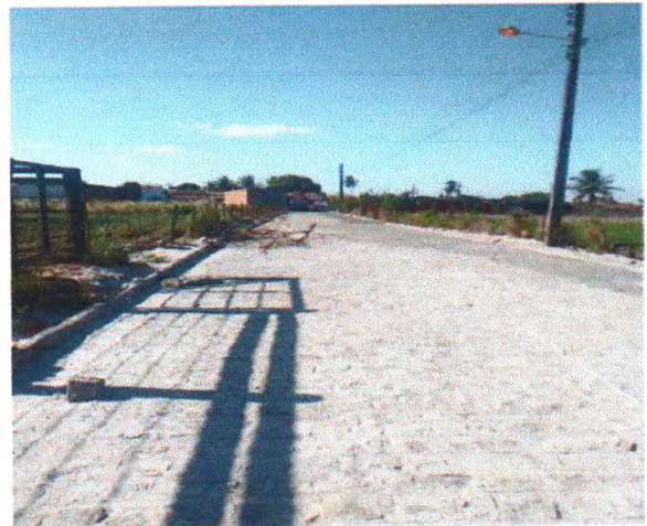
Foto 16: PAVIMENTAÇÃO DO TRECHO 02
