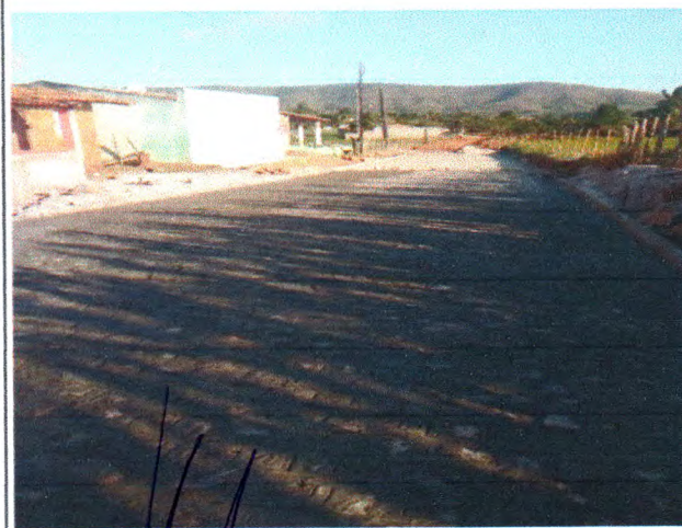
Foto 15: PAVIMENTAÇÃO DO TRECHO 02
