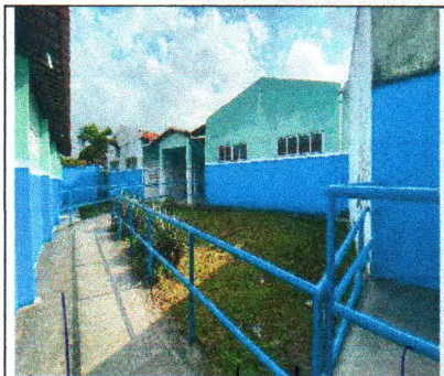
Foto 7: Vista das Salas do fundo
