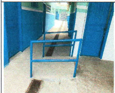
Foto 4: Acesso a sala nova
