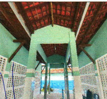
Foto 8: Vista da cobertura nova das salas do fundo
