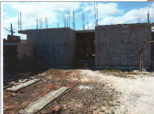
Foto 17: ALVENARIA DE VEDAÇÃO E CHAPISCO
