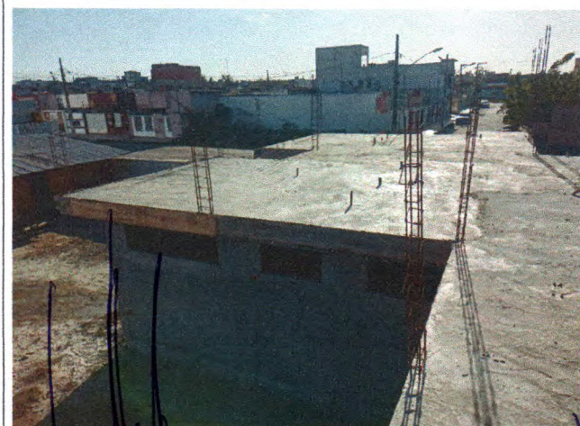
Foto 21: CONCRETAGEM DA LAJE
