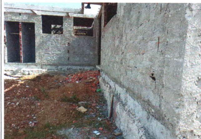
Foto 19: ALVENARIA DE VEDAÇÃO E CHAPISCO
