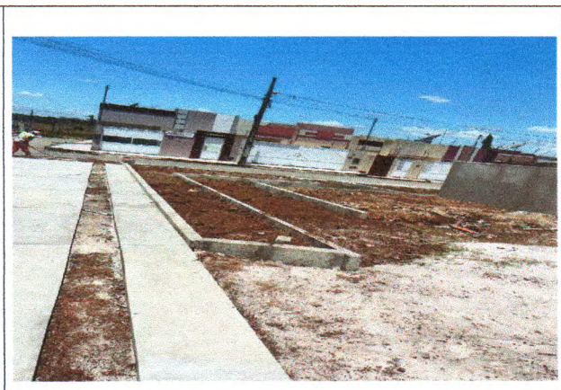
Foto 32: EXECUÇÃO DE CANTEIRO E PASSEIO
