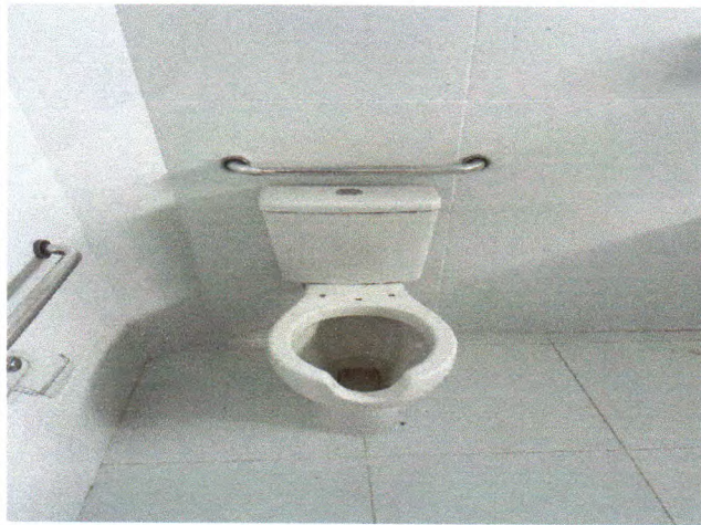
Foto 45: VASO SANITÁRIO E BARRA DE APOIO
