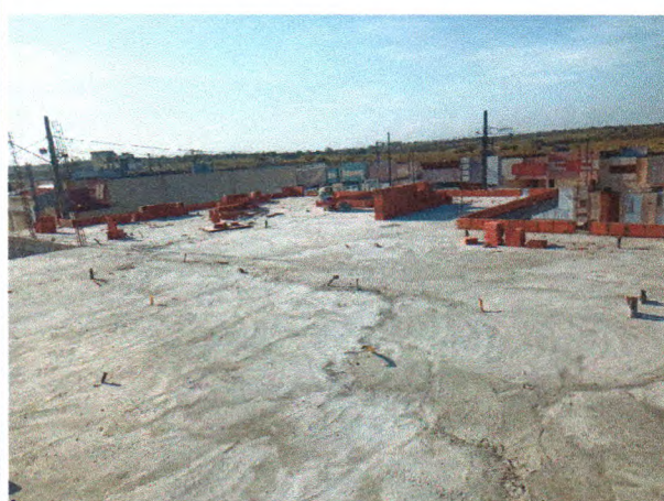
Foto 22: CONCRETAGEM DA LAJE
