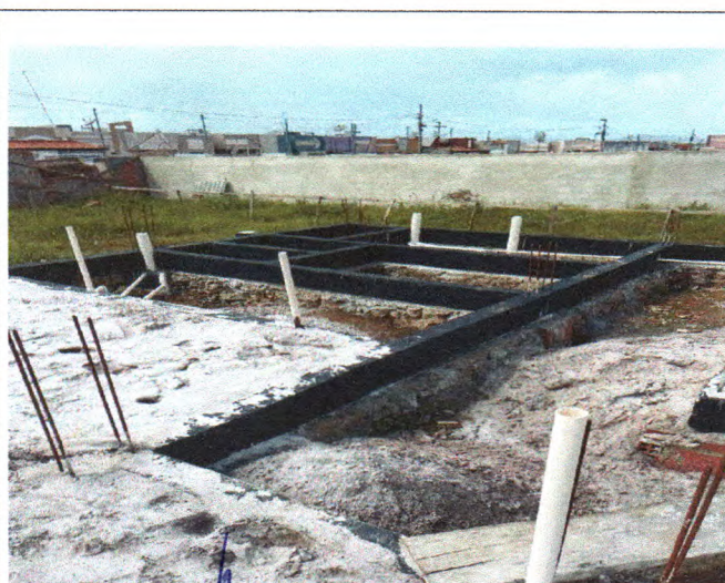
Foto 11: INSTALAÇÕES SANITÁRIAS E ATERRO
