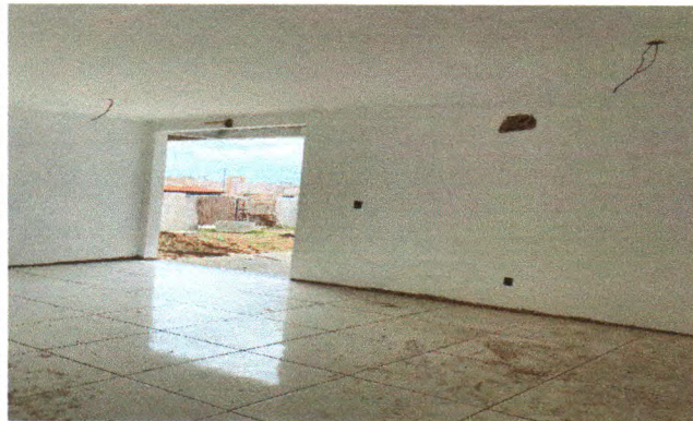
Foto 35: EMASSAMENTO, PISO E INSTALAÇÕES ELÉTRICA
