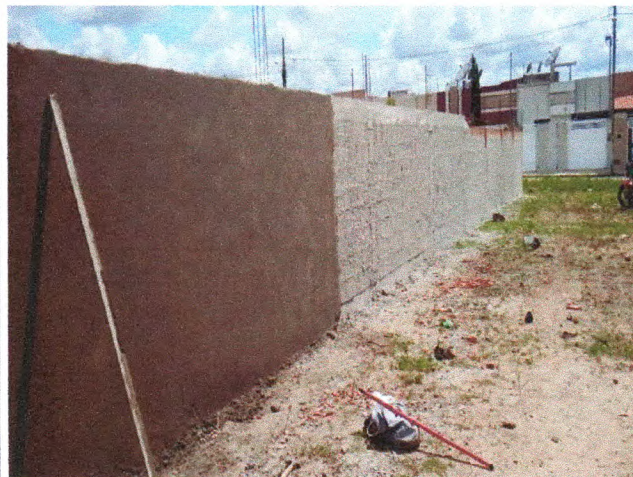
Foto 15: MURO EM ALVENARIA, CHAPISCO E REBOCO
