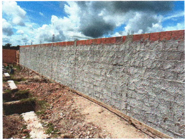
Foto 14: MURO EM ALVENARIA E CHAPISCO
