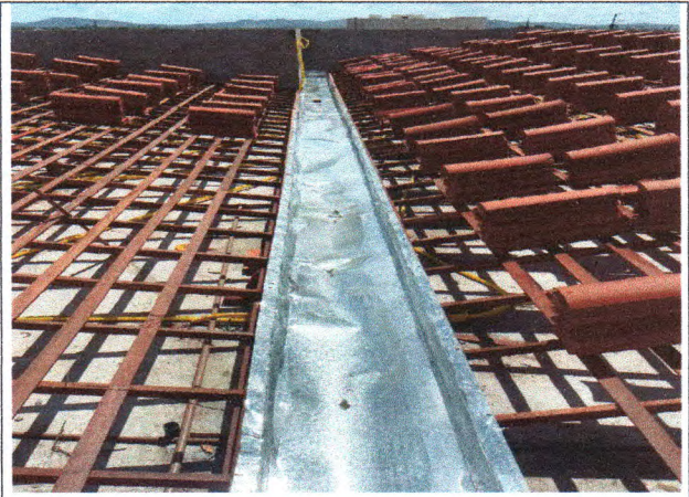
Foto 28: CALHA E COBERTURA EM MADEIRA
