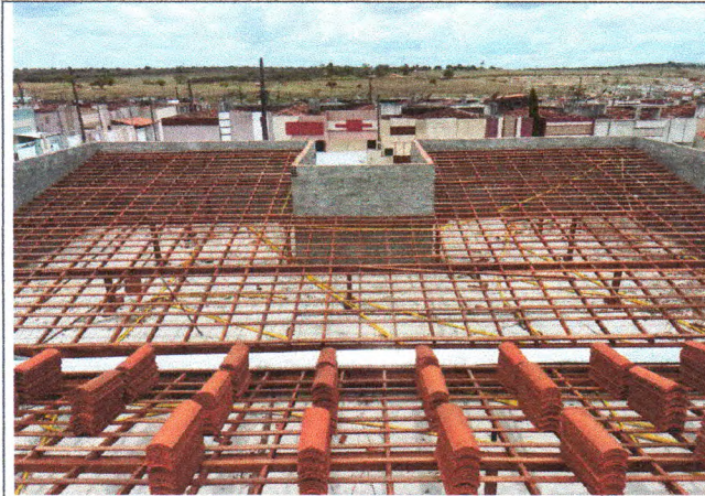
Foto 27: COBERTURA EM MADEIRA E TELHAMENTO
