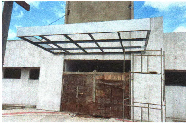
Foto 33: ESTRUTURA METALICA E SELADOR EXTERNO
