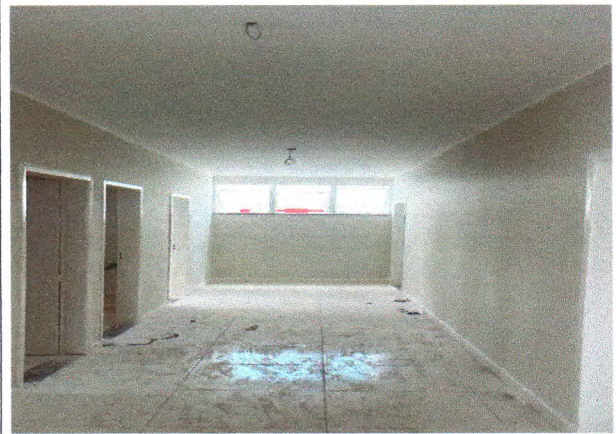
Foto 42: PORTAS EM MADEIRA, JANELA MAX-AIR
