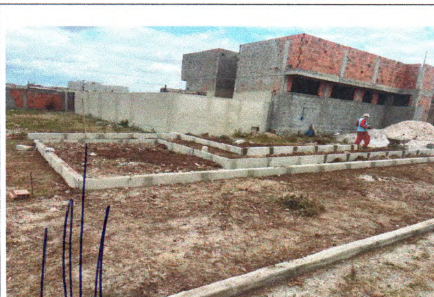
Foto 31: EXECUÇÃO DE CANTEIRO E PASSEIO
