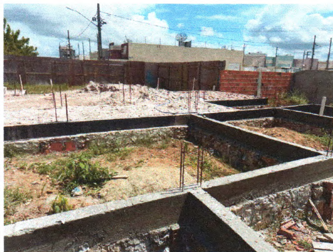
Foto 09: VIGAS BALDRAMES E PILARES
