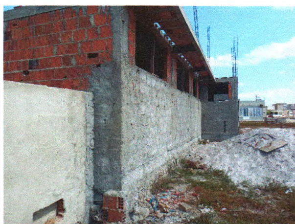
Foto 20: ALVENARIA DE VEDAÇÃO E LAJE
