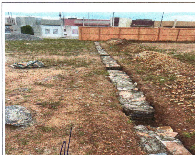
Foto 07: ALVENARIA DE PEDRA
