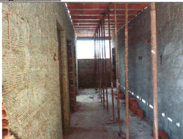
Foto 18: ALVENARIA DE VEDAÇÃO E LAJE
