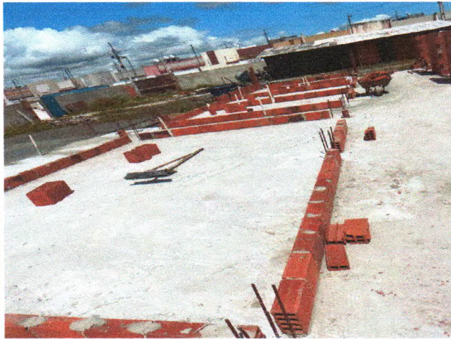
Foto 13: ALVENARIA DE VEDAÇÃO
