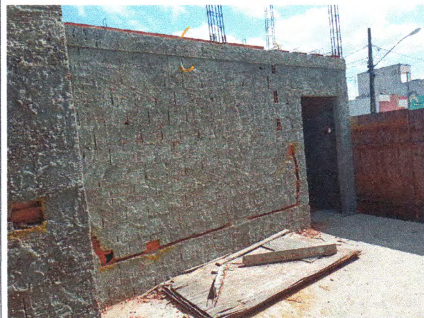
Foto 16: ALVENARIA DE VEDAÇÃO E CHAPISCO
