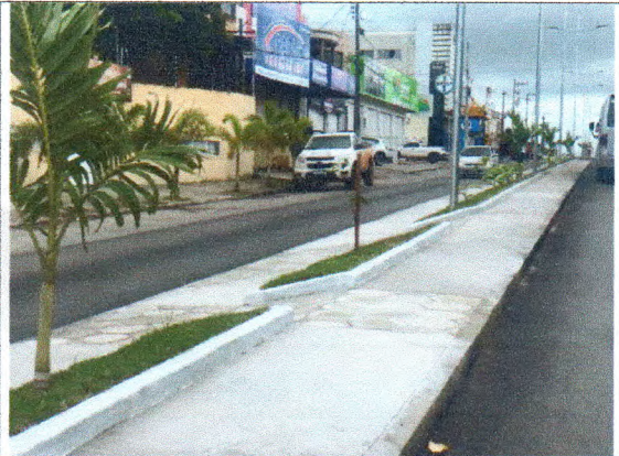
Foto 02: Vista geral Piso Concreto, Poste e Iluminação
