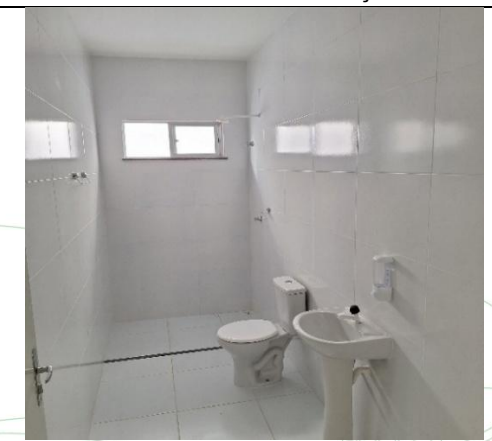
Foto 12: Banheiro de servidores
