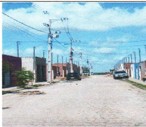
RUA NOEL JOSÉ DE SANTANA – RUA N
