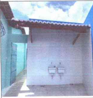
Foto 26: Área de Serviço (Ampliação)
