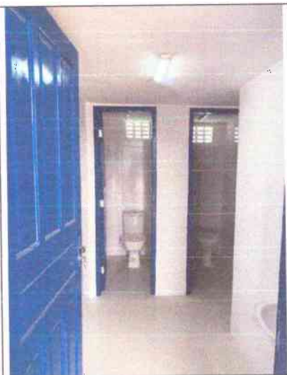
Foto 20: Banheiros já existentes
